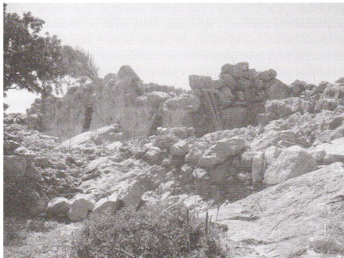
Choiromandres, pohled na hlavní budovu „guard house“ (středně mínojské období I/II – pozdně mínojské období I)
